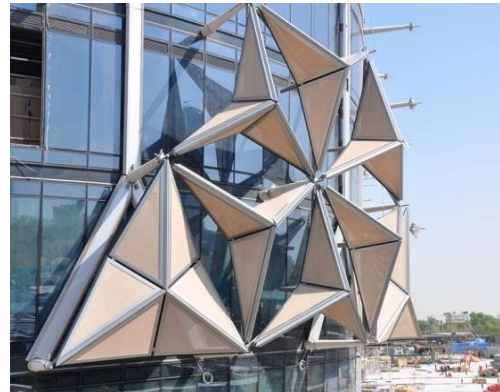
الشكل (5): وحدة المشربية المكوّنة من ستة إطارات مثلثة (Karanouh and Kerber,2015).
