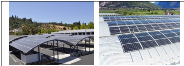
الشكل(٨): توضع الخلايا الشمسية في الأسطح المقوسة
