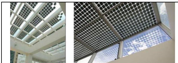
الشكل (4): توضع الخلايا الشمسية كأسطح شفافة المصدر: [10]
