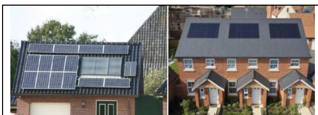
الشكل (6): توضع الخلايا الشمسية على الأسطح المائلة فوق مواد الاكساء المصدر: [11]
