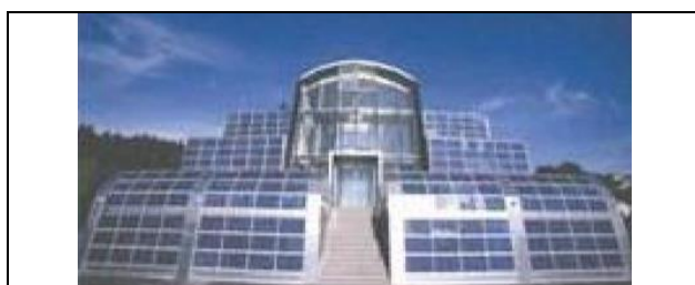
الشكل (١٢): جدران خلايا الشمسية ذات أشكال منحنية المصدر: [7]
