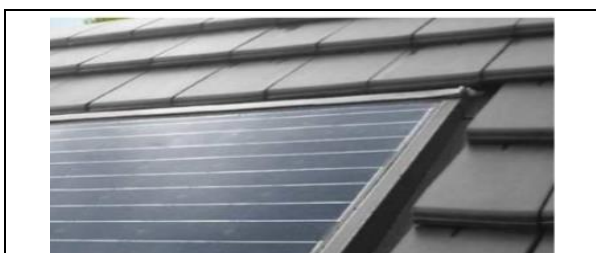
الشكل (5): توضع الخلايا الشمسية على الأسطح المائلة بديل مواد الاكساء المصدر: [11]
