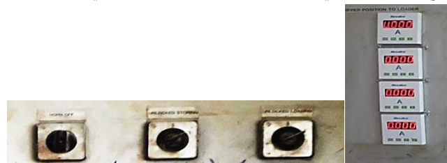
الشكل (4): مقاييس التيار مع قواطع التشغيل الخاصة بالمحرك
