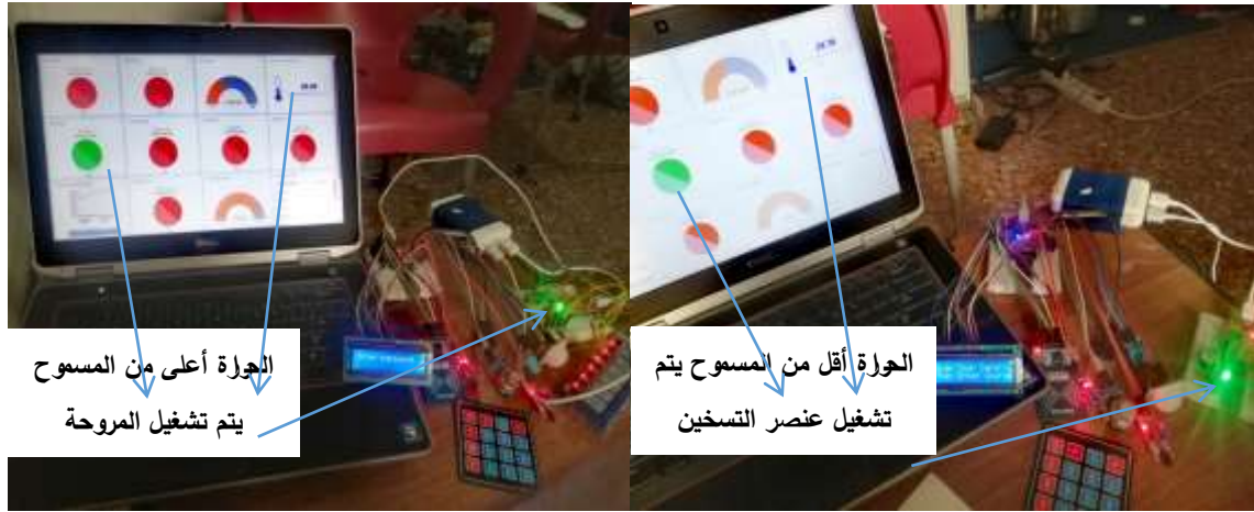
الشكل (28): اختبار نظام التدفئة والتبريد HVAC
