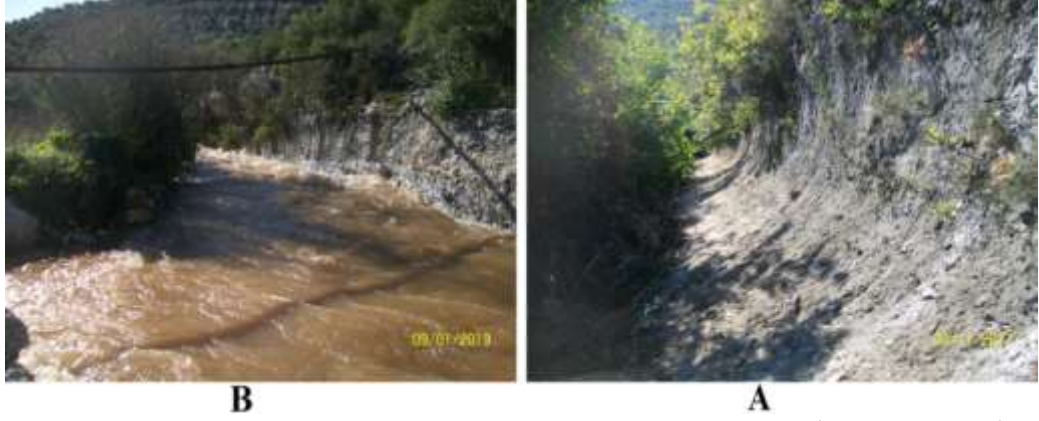
الشكل رقم 8: يوضّح النفق السفلي المحفور بشكل نصف دائري في صُحُور الجوراسي (A). وجريان المياه العكرة التي تخرج من كهف الحومة خلال النفق السفلي (B).
