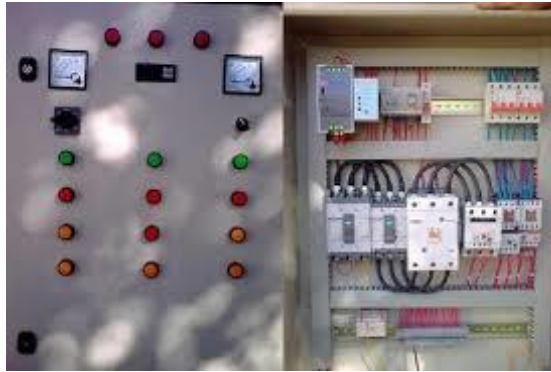
الشكل (5). صور للوحة التحكم الخاصة بنفق البسترة.
