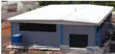
الشكل (3): سقف بألواح سندويشية لمعمل محلي
