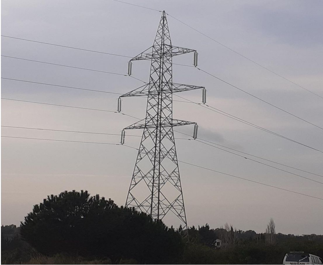
الشكل (6): أبراج التوتر العالي ذات الدارة المزدوجة
