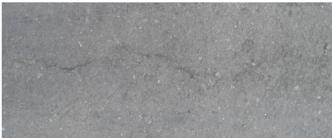
الشكل رقم ١٣ : ظهور شقوق سطحية شعرية في اماكن محدودة
