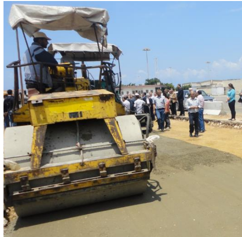
دحي البيتون بشكل مباشر بعد فرشها باستخدام المدحلة المساة وزن ١٤ طن و رج الطبقة
