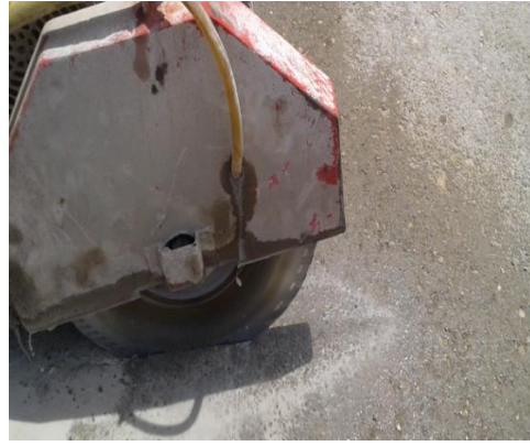
تنفيذ فواصل عرضية للببتون بعمر ١٢ ساعة ( يظهر المقطع الصلب للببتون المنشور و سطح الببتون المكتنز )
