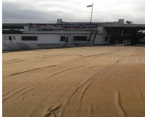
دحي البيتون بشكل مباشر بعد فرشها باستخدام المدحلة المساة وزن ١٤ طن و رج الطبقة
