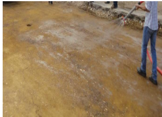
اعداد طبقة الاساس ( ترطيب) قبل تنفيذ طبقة الببتون المنفذ بالمداحي
