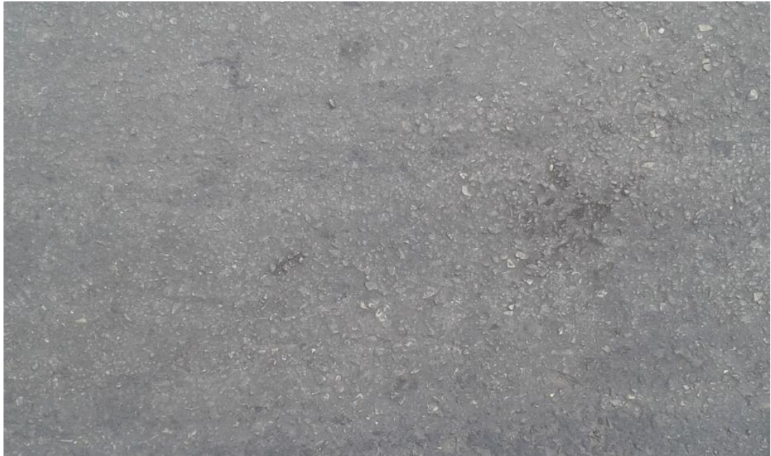
الشكل رقم ١٢: حالة السطح في اغلب مناطق الرصف ( ٦٠ يوم )
